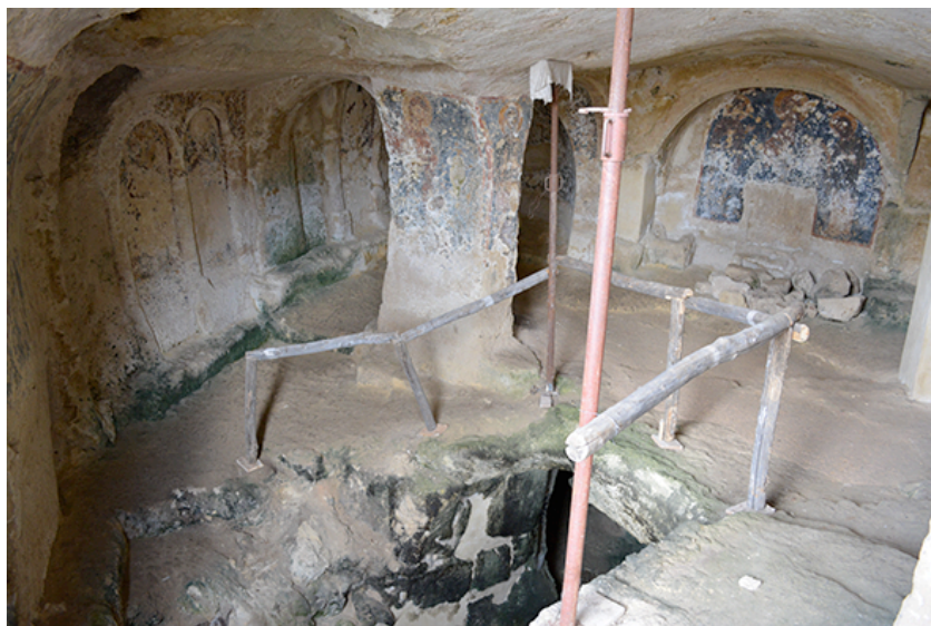
Fig. 3. Casalrotto presso Mottola (TA), chiesa di Sant'Angelo: veduta della chiesa superiore e vano con la rampa di accesso alla chiesa inferiore
