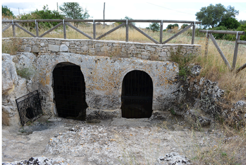
Fig. 2. Casalrotto presso Mottola (TA), chiesa di Sant'Angelo: ingresso alla chiesa
